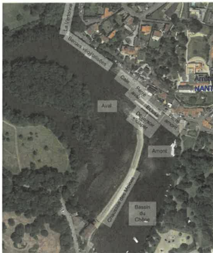
Carte 2. Vue aérienne de l'emprise du projet (Chaussée des moines, déversoir et écluse) Sources : Arcadis 2021, Google earth
